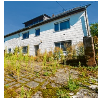
In diesem Haus in Trugenhofen wohnte Helmut Strigl. An den Haustüren sind noch die Spuren der Polizeiarbeit zu sehen.
