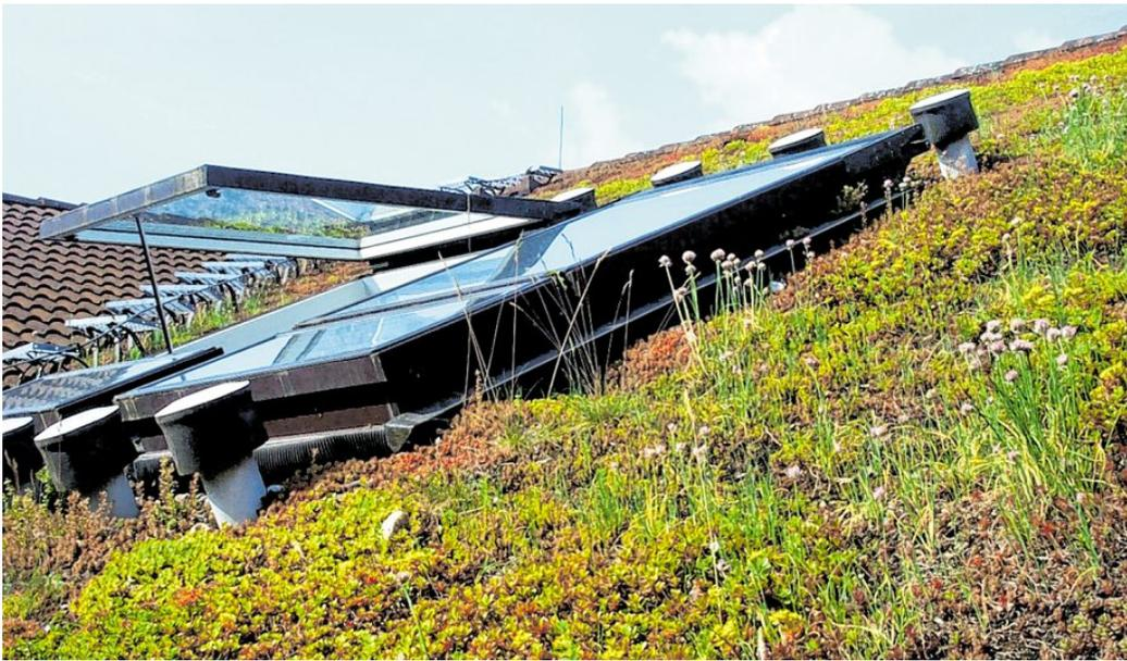
Die Dach- und Fassadenbegrünung ermöglichen die Speicherung sowie Vor-Ort-Versickerung von Regenwasser, entlasten die Kanalisation und beugen damit Starkregenschäden vor. Fotos: BGL
