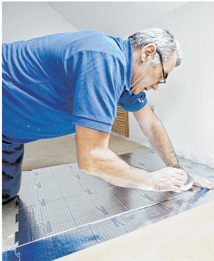
Wer zwischen Bodenbelag und Estriche dämmendes Material verlegen lässt, baut Problemen mit Lärmbelästigung durch Trittschall vor.
